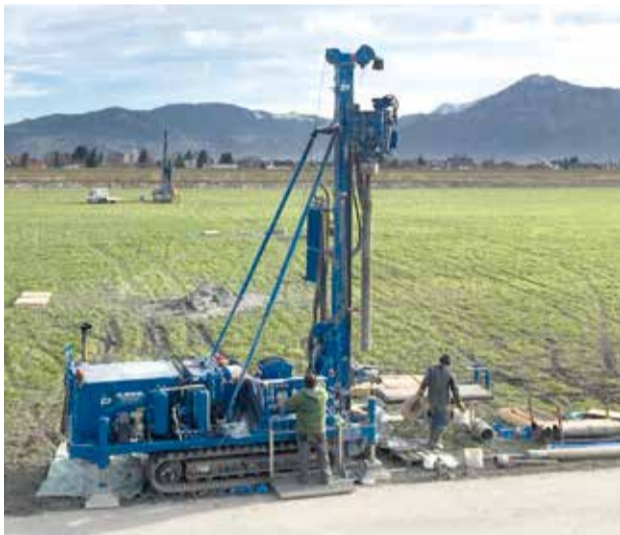
Bohrungen von Versuchsbrunnen im Rheinvorland von Widnau.
