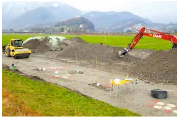
Beginn Bau Versuchsdamm in Meiningen.
