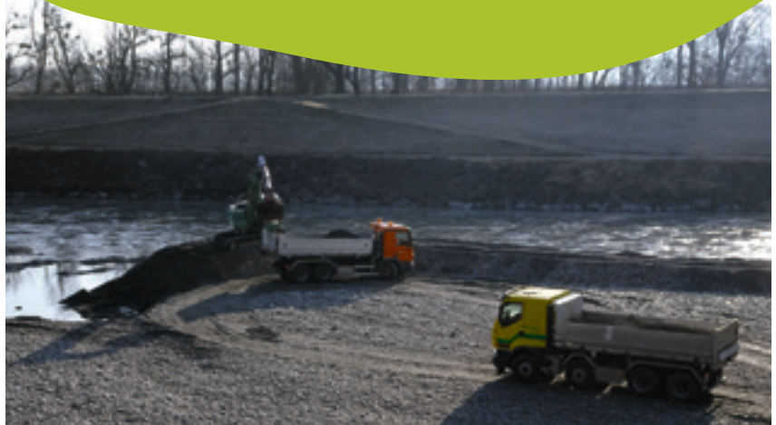
Künftig wird das Geschiebe zusätzlich von Sandbänken bei Rüthi und Diepodsau entnommen.
