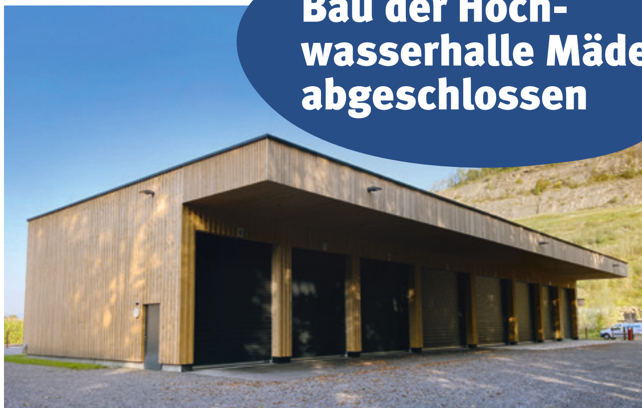
Der Hochwasserstützpunkt mit der neuen Hochwasserhalle in Mäder.
