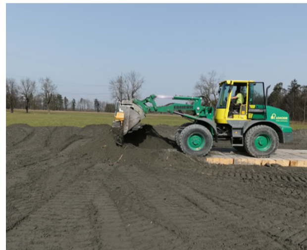
Baggermatrizen verhindern die Verdichtung des Bodens.
