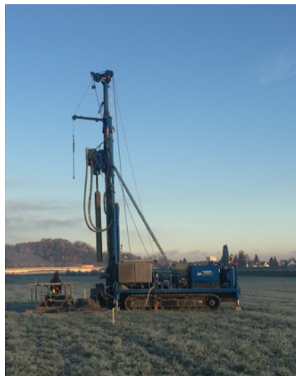
Probebohrung im Rheinvorland.
