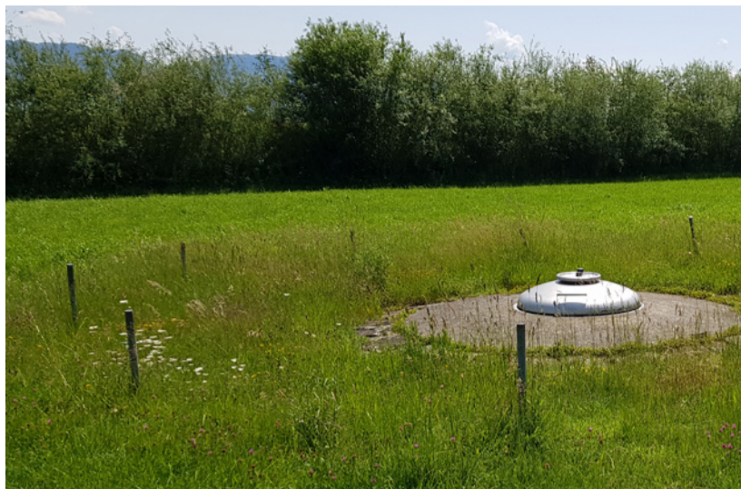
Trinkwasserbrunnen im Rheinvorland. Die Schutzzone 1 ist gut erkennbar.
