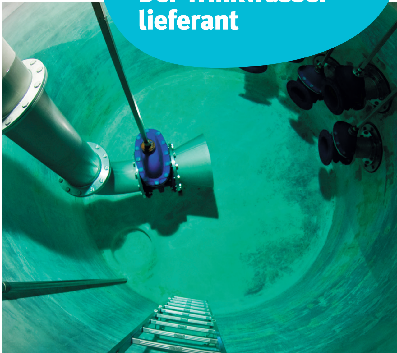
Blick in einen Trinkwasserbrunnen.
