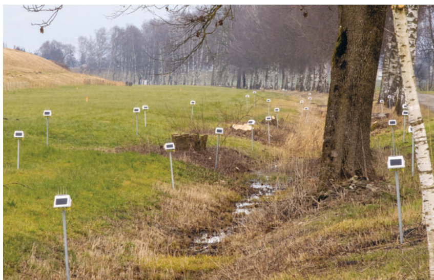
Messsensoren entlang des Sickerkanals.
