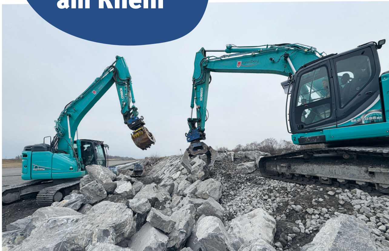
Arbeiten an der Mittelwuhre.
