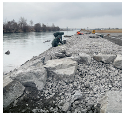
Bauarbeiten an der Rheinvorstreckung.
