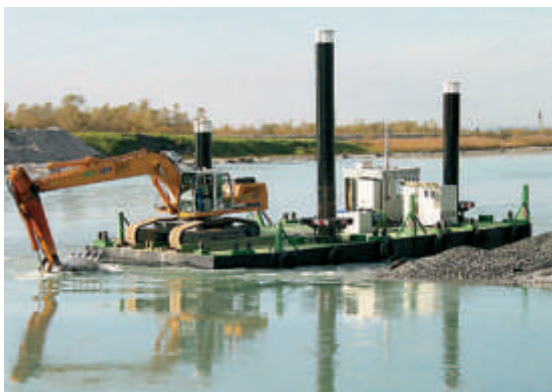
Der Geschiebehalt kann mit Entnahmen (Mündung Bodensee) oder Zugaben beeinflusst werden (Geschiebemanagement)
