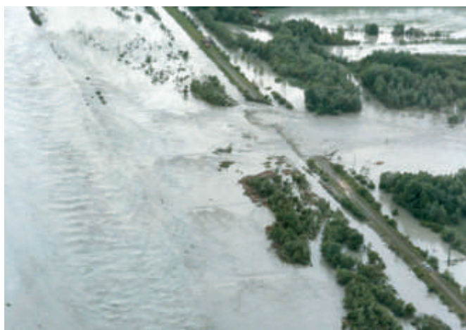
Dammbruch bei Fussach beim Hochwasser von 1987.
