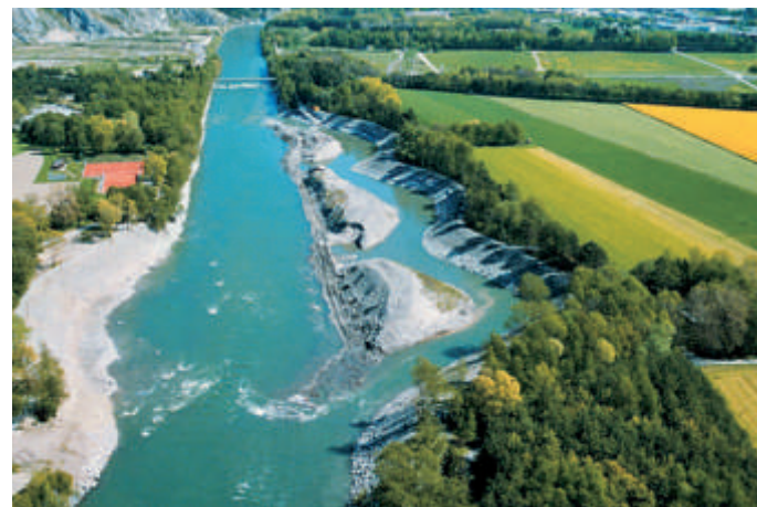
Uferschutzsanierungsmassnahmen als Chance für die kurzfristige Realisierung von Flussaufweitungen am Beispiel Chur/Felsberg
