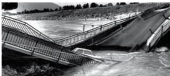
Wegen der Eintiefung des Flussbetts stürzte 1972 die Brücke Schaan-Buchs ein. Nach dem Brückeneinsturz wurden zahlreiche Kiesentnahmen eingestellt
